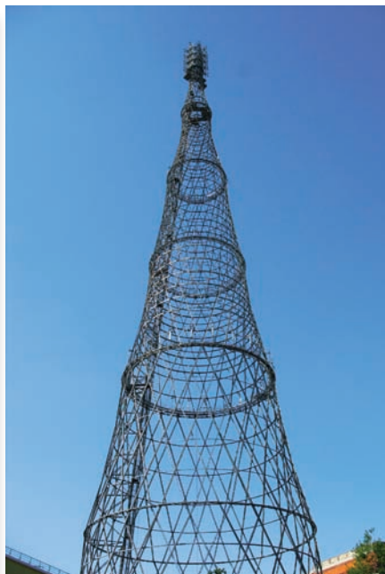
Шуховская башня на Шаболовке
